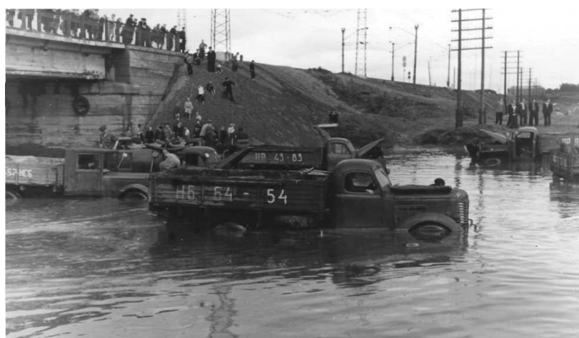
Наводнение на пл.Труда и Энергетиков.
