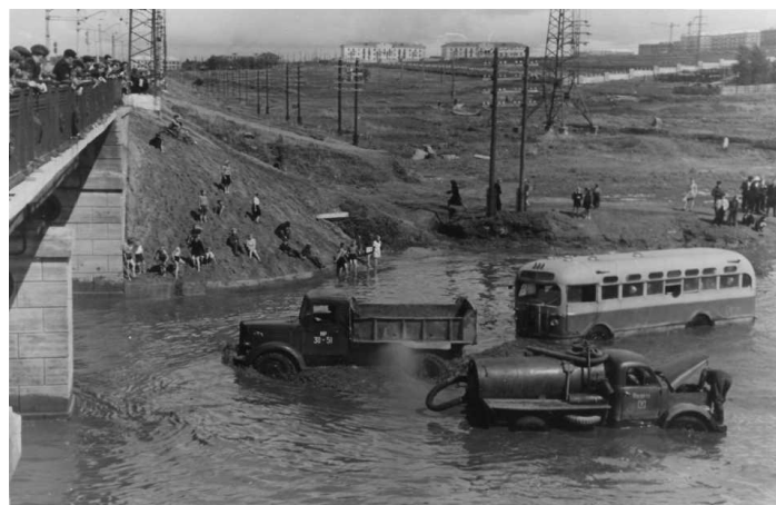
Наводнение на пл.Труда и Энергетиков.
