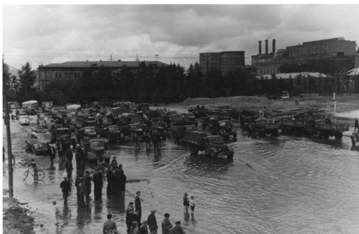
Наводнение на пл.Труда и Энергетиков.
