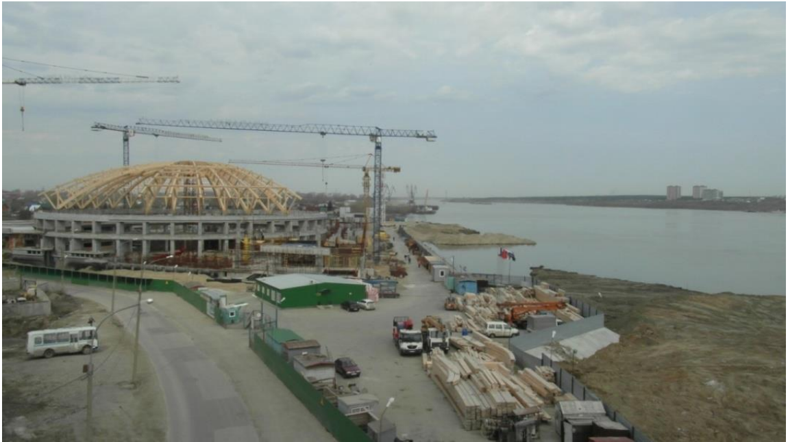
Строительство «Аквапарка». 02.05.2015г. 5042
