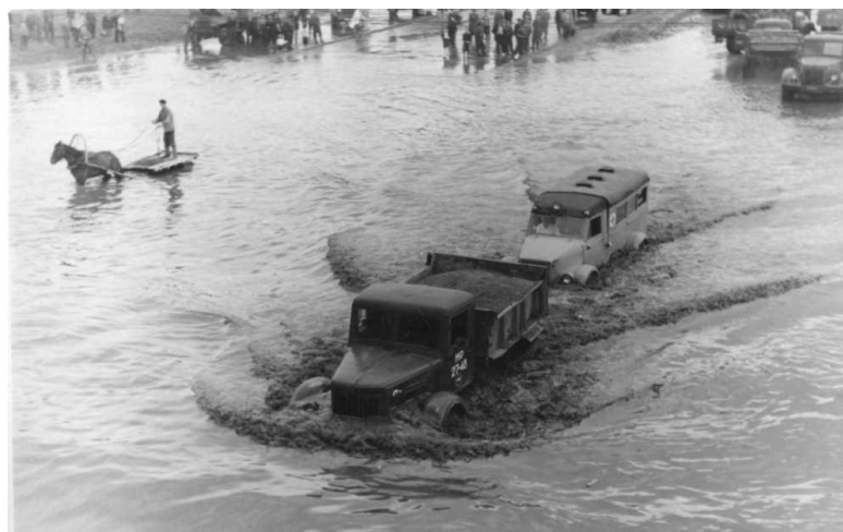
Наводнение на пл.Труда и Энергетиков.
