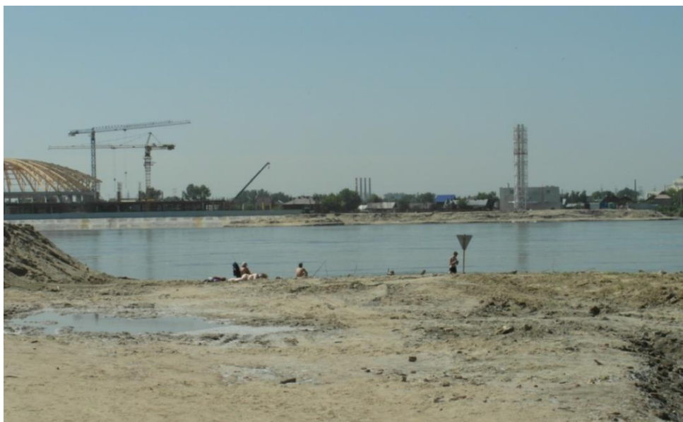
Створ понтонного моста. 07.06.2015г. 5737
