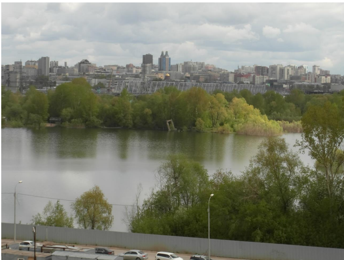
Котлован в пойме левого берега. 04.06.2013г. 028
